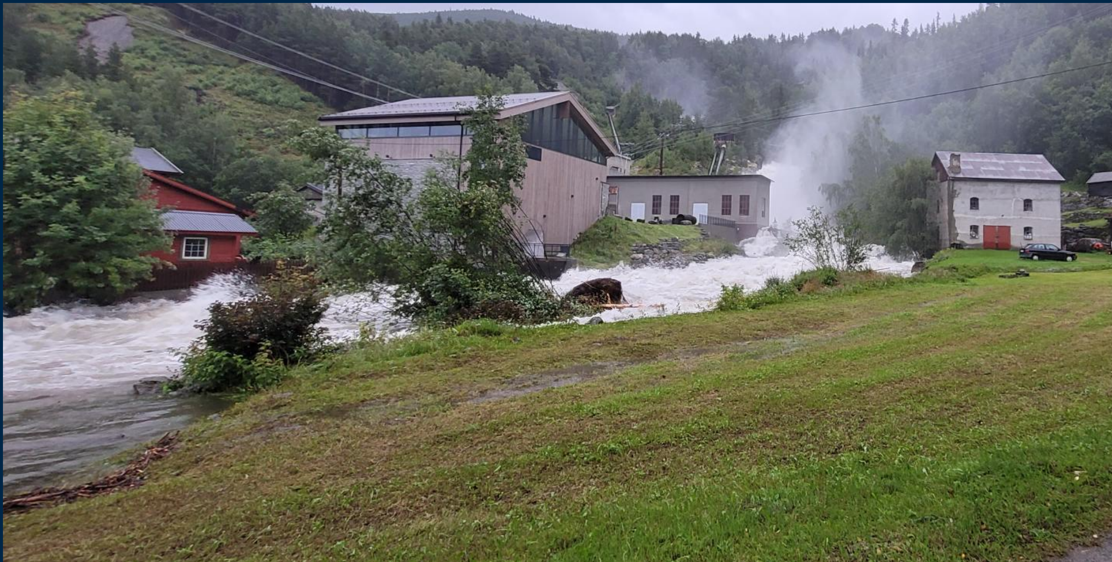
FLOMMEN «HANS». Det har aldri vært målt så stor vannføring i Tesse-vassdraget. Bildet er fra Nedre Tessa 1 Kraftverk med vannføring på ca. 100 kubikkmeter pr. sekund.
