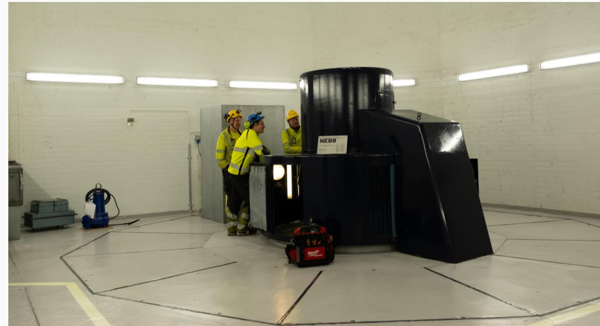
Arbeid i Eidefossen kraftverk. Foto: Smelt Media AS
