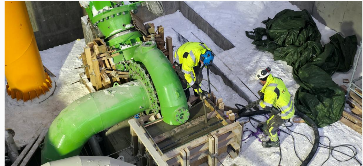
Arbeid med bygging av Ula Kraftverk. Foto: Eidefoss Vannkraft AS
