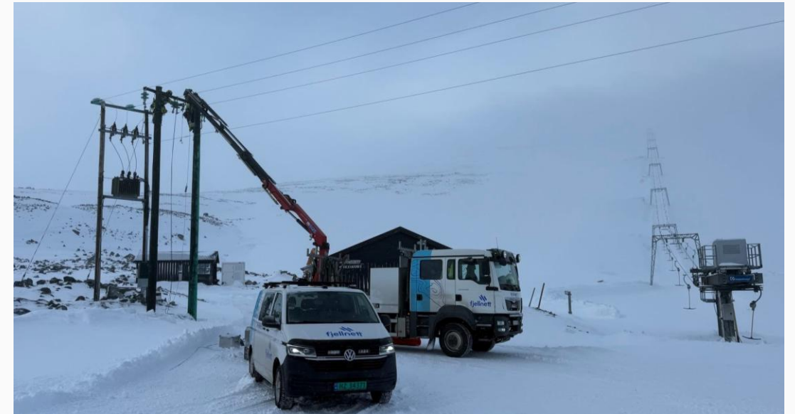
Fjellnett har Norges høyeste beliggende strømnnett, her fra arbeid med strømnettet ved Juvasshytta og Galdhøpiggen Sommerskiserter, 1841 meter over havet. Foto: Fjellnett AS
